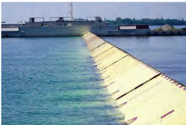
闸门模块抬起时的状态，威尼斯泻湖将与亚德里亚海形成水位落差（图片来源：MOSE官网）
